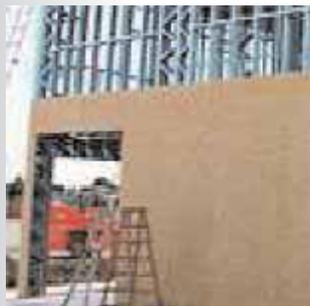
Una volta completata la struttura, la costruzione viene rivestita, all'interno e all'esterno, con pannelli in cemento, dotati di intercapedine colmata con materiale eco-compatibile che ne costituisce la massa termica.
